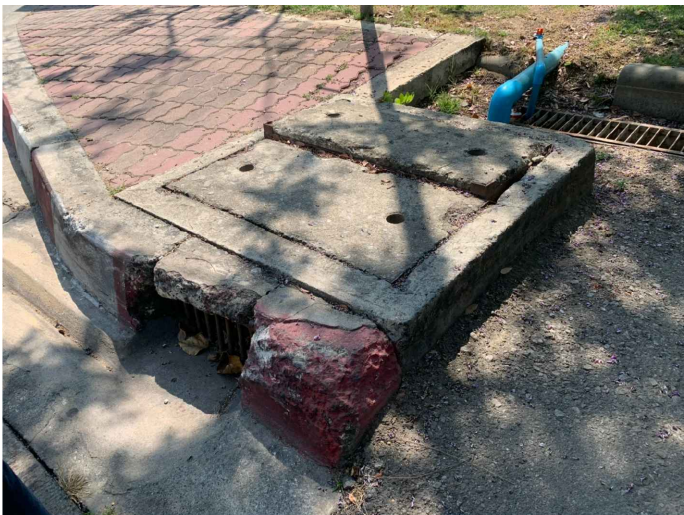
บ่อพักน้ำติดตั้งใหม่ ปรับระดับขอบบ่อให้อยู่ในระดับเดียวกันกับถนน
